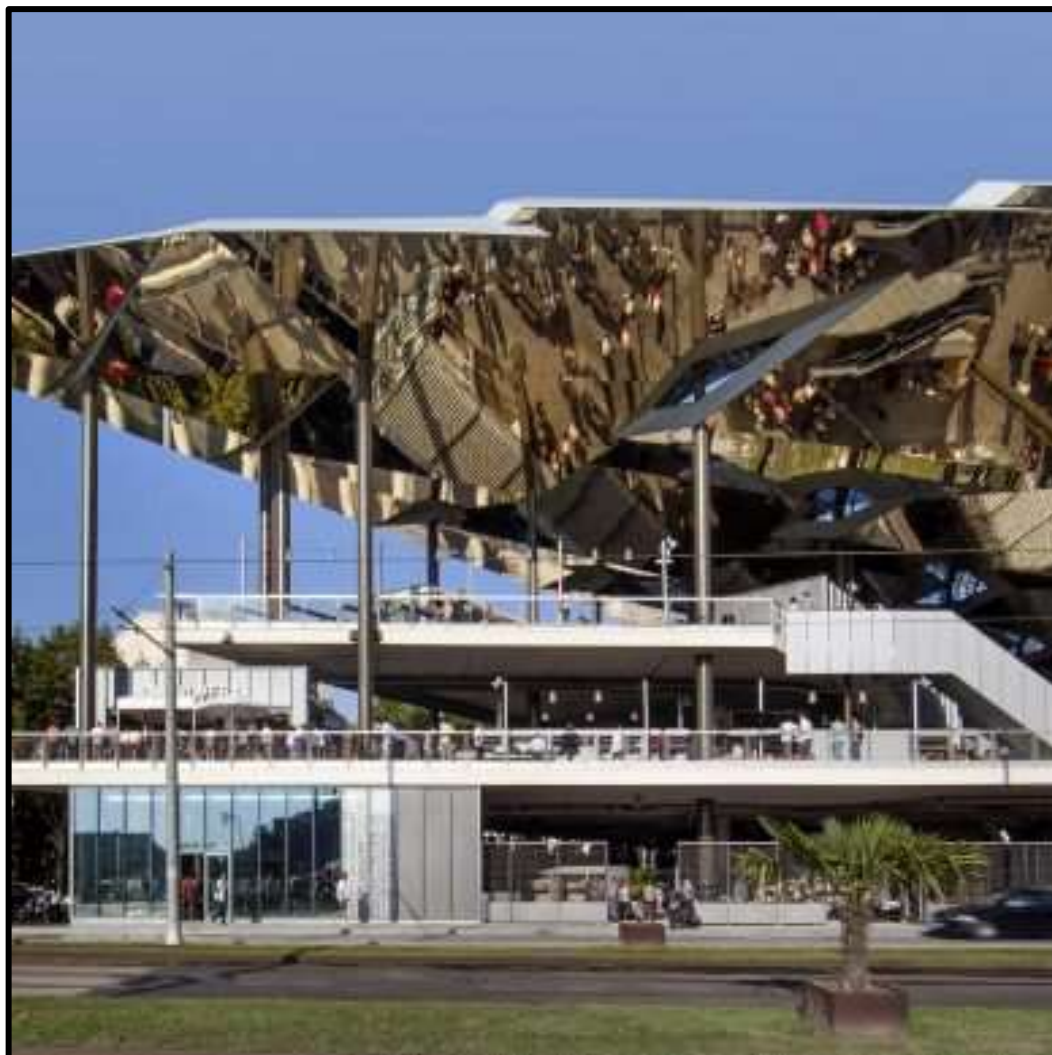
Figura 20- Cobertura espelhada/ Mercat del Encants - Barcelona
