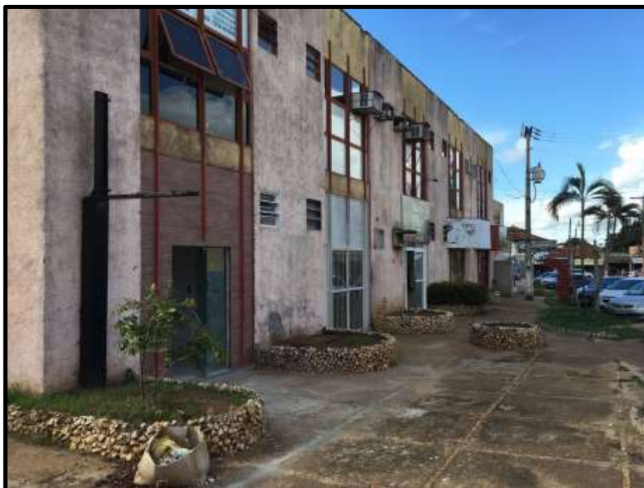
Figura 34 - Vista da Área de Intervenção
