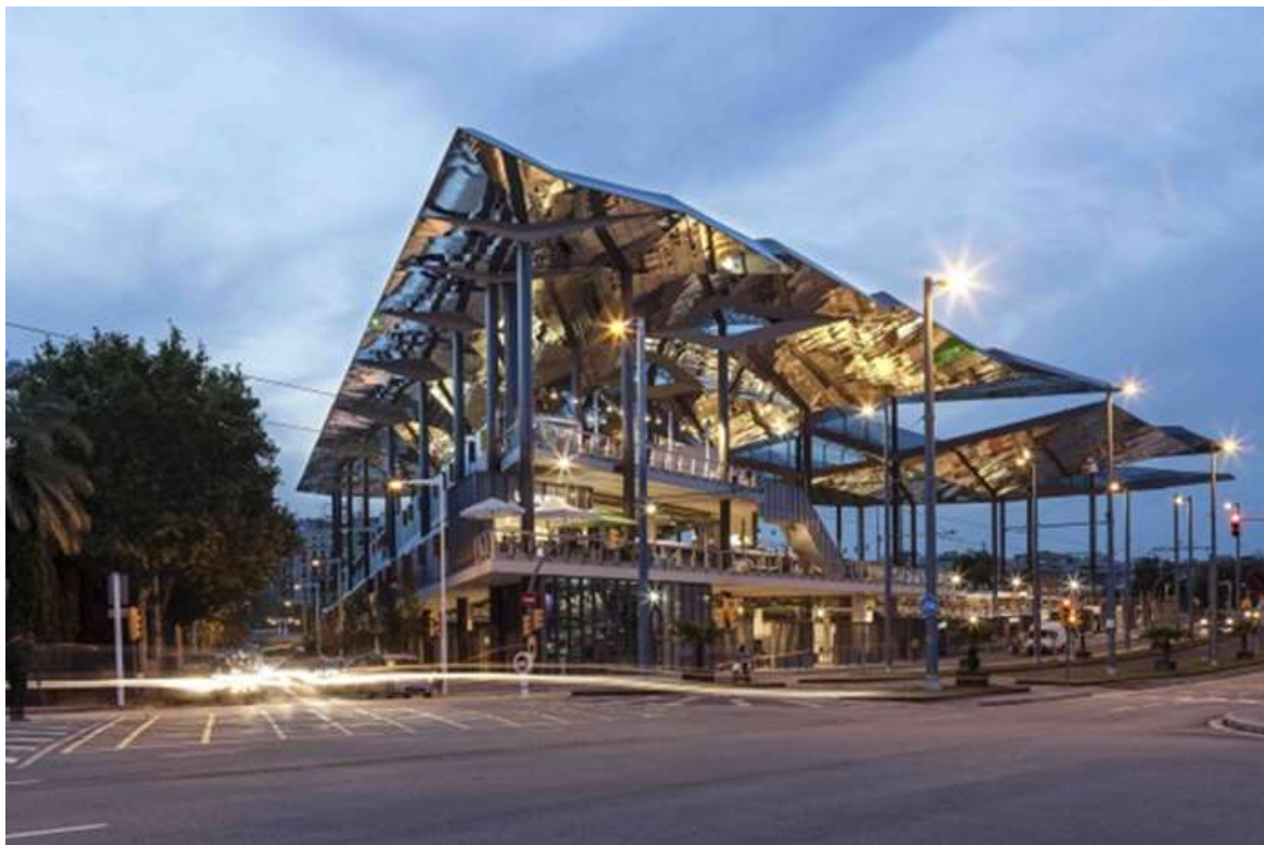
Figura 15 - Fachada Frontal do Mercat del Encants - Barcelona
