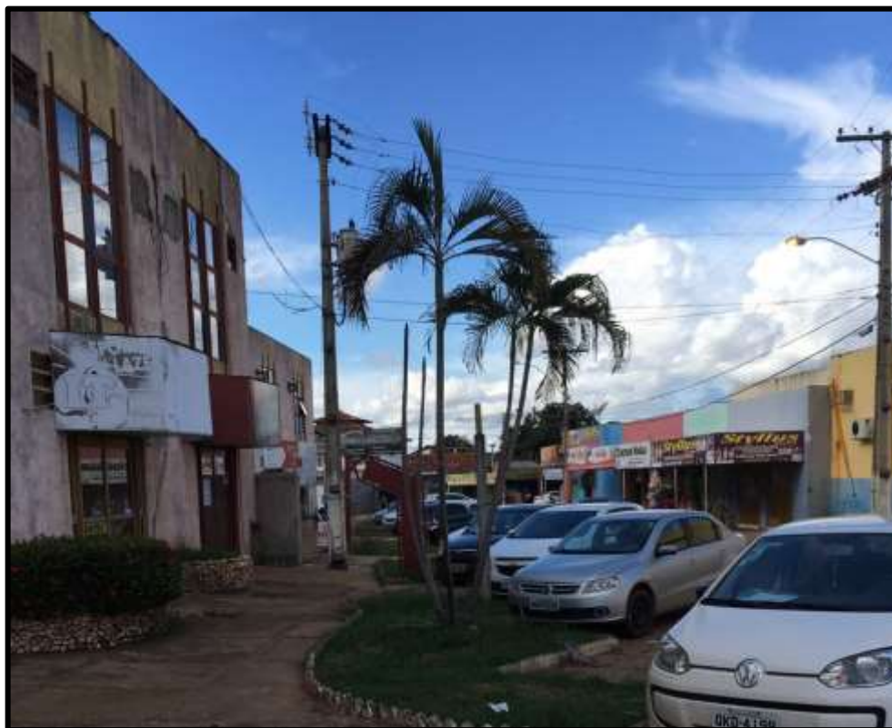
Figura 35 - Vista da Área de Intervenção
